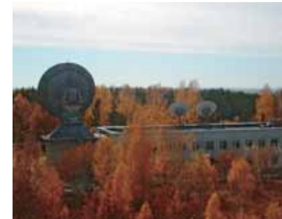
Сибирский научно-исследовательский центр космической гидрометеорологии «Планета» (вверху – уникальная антенна ТНА-57 Р высокого пространственного разрешения с диаметром зеркала 12 м)
